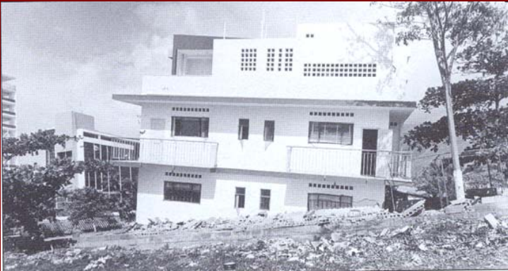
Fig. 23. Casa afectada por el fenómeno de licuación. Caraballeda, Litoral Central, año 1967.
