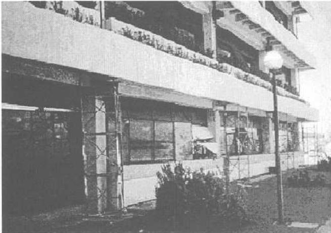
Foto 7 Columnas perimetrales dañadas en la fachada lateral derecha. Nótese la ausencia de tabiquería y la presencia de jardinería
