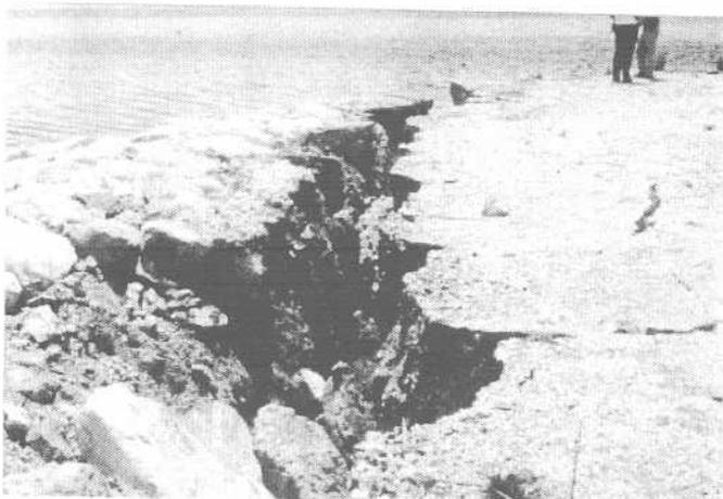
Foto 3 Desplazamiento lateral en terreno compactado en planta industrial en Marigüitar
