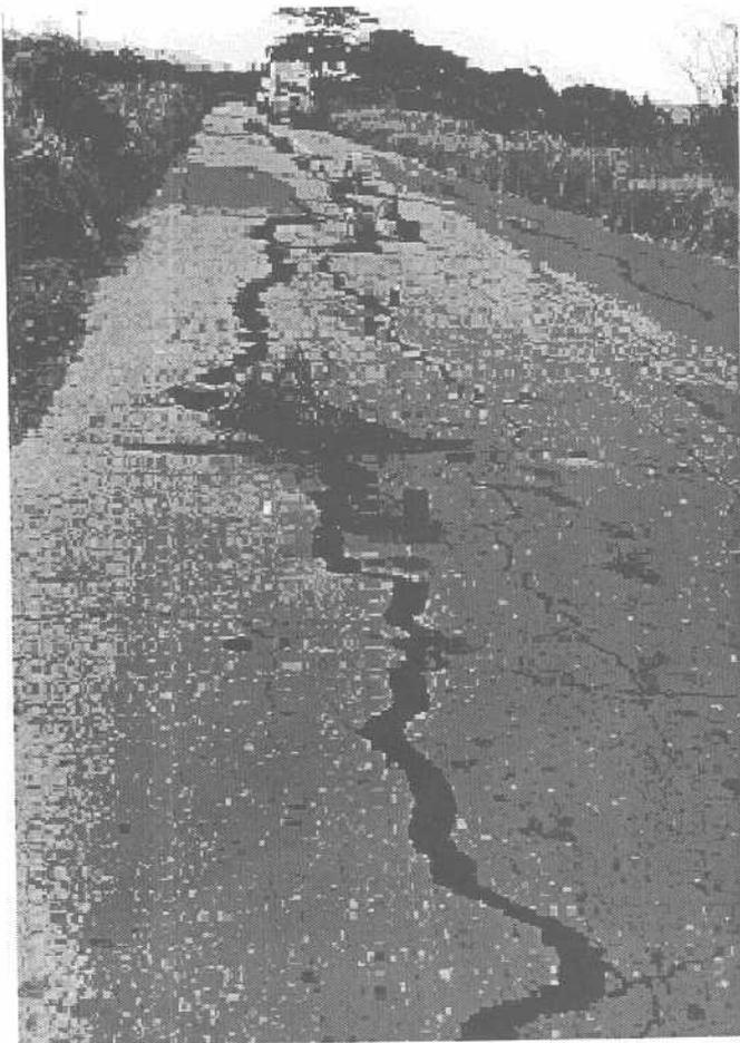
Foto 11 Grieta longitudinal de unos 200 metros debido a fallas del terreno. (foto cortesía L.Montes).
