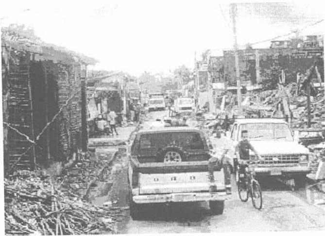
Foto 9 Vista general de una calle de Cariaco tres días después del terremoto. Nótese la calidad del material de las viviendas colapsadas
