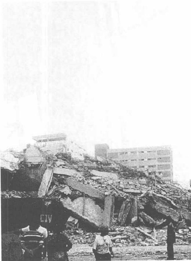
Foto 6 Vista general del colapso del edificio Miramar. Nótese la forma de panqueca en que quedaron las placas.
